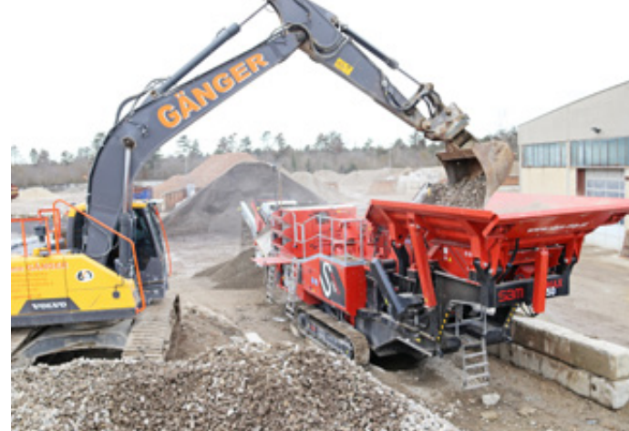
Die neue SBM Remax 450 bei der Aufbereitung von Gleisschotter zu hochwertigem Gradermaterial.
